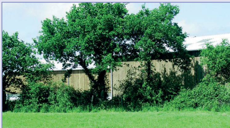
Photographie issue de l'ouvrage : "un nouveau bâtiment agricole : pourquoi ? comment ?" CAUE - DDA du Calvados (1984)
