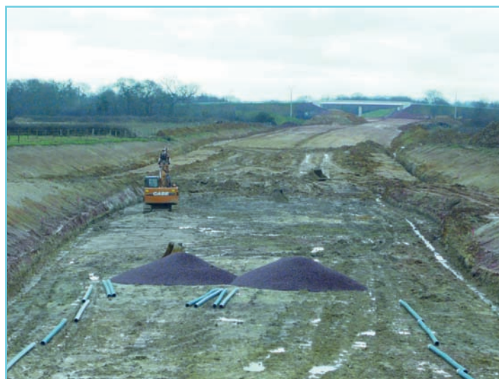
Travaux de la RN174, à Saint-Jean-de-Daye
