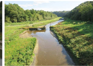
4. Juin 2017 : situation juste avant le démarrage des travaux. Deux années de gestion à la cote hivernale ont permis à la végétation de recoloniser entièrement les berges exondées grâce à une banque de graines importante naturellement présente dans les sédiments et à la richesse du sol.
