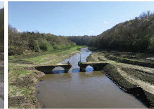
10. Avril 2018 : la forte hydrologie de l'hiver 2017-2018 a permis un hydrocurage important et attendu du lit mineur de la Sélune avec une évolution significative de ses berges. Les sédiments partis par hydrocurage seront repris par les méthodes terrestres dans la partie aval de la retenue, encore en eau.
