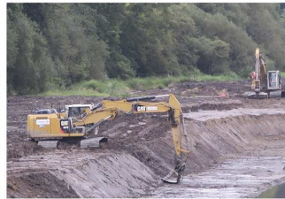
7. Août 2017 : des "banquettes" (environ 5 mètres de largeur) sont réalisées pour permettre à la rivière de se comporter naturellement en débordant de son lit mineur quand les débits augmentent.
