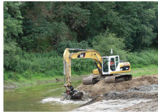
6. Juillet 2017 : zoom sur une pelleteuse type "marais" qui est à l'œuvre pour extraire les sédiments du lit mineur et les déposer sur la rive. Ils sont repris par d'autres pelleteuses qui les transfèrent vers des casiers de stockage créés dans les limites de la retenue.
