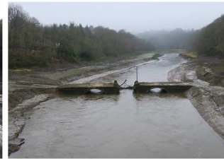
9. Janvier 2018 : les fortes précipitations du début du mois ont généré des débits importants (80 m 3 /s). Les banquettes jouent parfaitement leur rôle d'espace d'expansion de la sa vallée en modérant son lit mineur et ses berges par son propre écoulement lui redonnant un aspect naturel.
