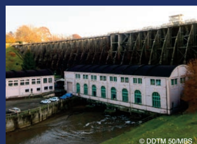
Le bâtiment usine, première étape de l'opération d'effacement du barrage de Veziens
